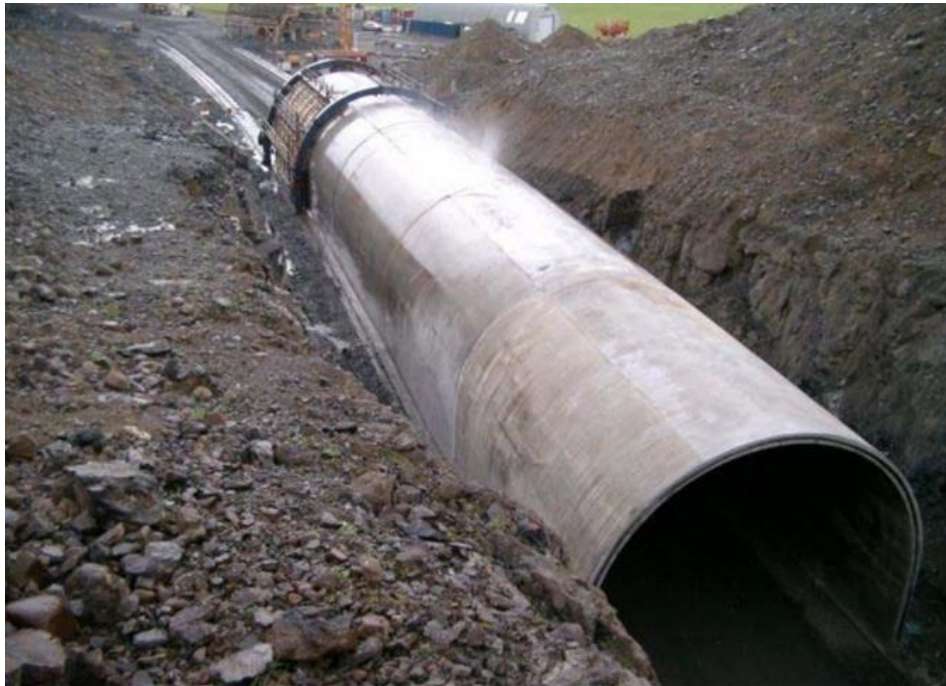
Mynd 8.17 Bygging vegskála í Fáskrúðsfirði (Ljósmynd: Sigurður Oddsson, ágúst 2004).
